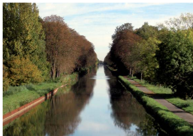
Dans le Ried, la réalisation de la piste cyclable le long du Canal a débuté
