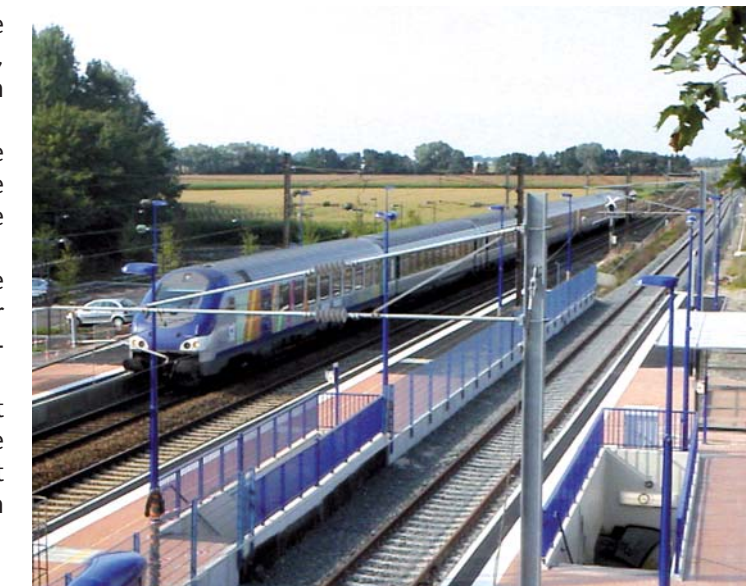
La troisième voie sera opérationnelle en décembre 2009
